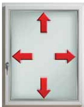
Il vetrocamera viene inserito nel telaio e centrato.
